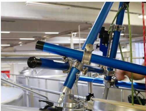
Fijación de tuberías de union Figura 15
